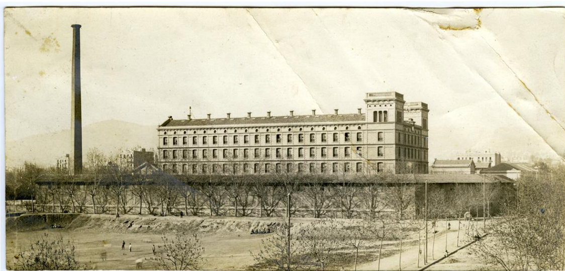
Vista general de Can Batlló (1911). Autor: Ballell Maymí, Frederic
